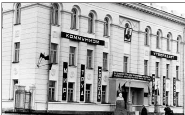
Здание Печорского горкома КПСС
