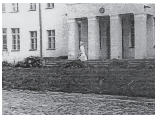
Перед главным корпусом больницы № 8. Покрытием площадки служат деревянные чурки, перед входом посажены кусты ревеня. 1954 г.
