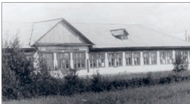
Хирургический корпус больницы № 9. 1960 г.
