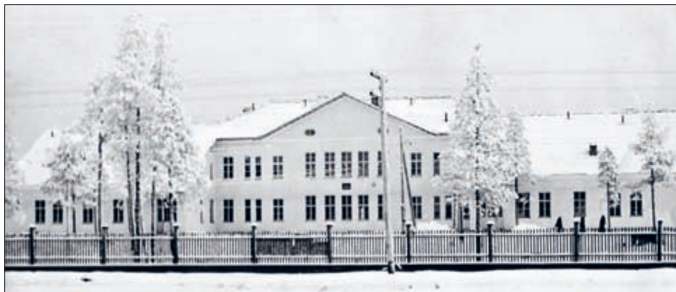
Главный корпус райбольницы, 1959 г.
